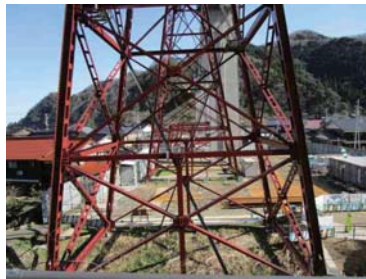
旧余部鉄橋の橋梁の一部が残されていた
