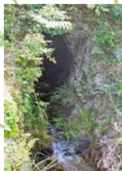
西谷公園底樋管
